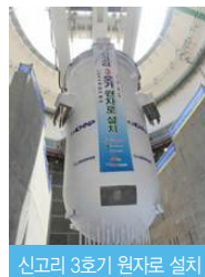
신고리 3호기 원자로 설치
