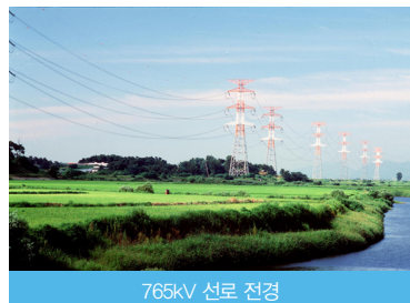
765kV 선로 전경
